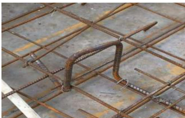
Trái: thép neo trên sàn bê tông đổ tại chỗ. Phải: thép neo chôn sẵn trên sàn bê tông bán lắp ghép.
