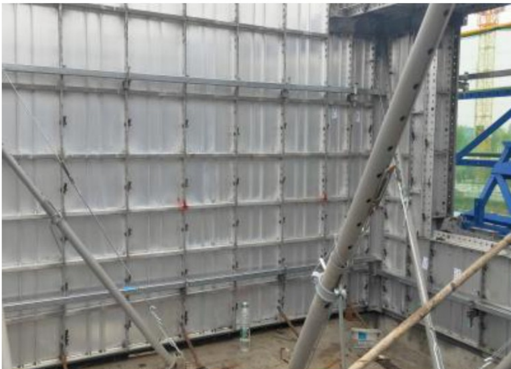
Hệ gông thép hộp đã lắp trên cốt pha tường.
