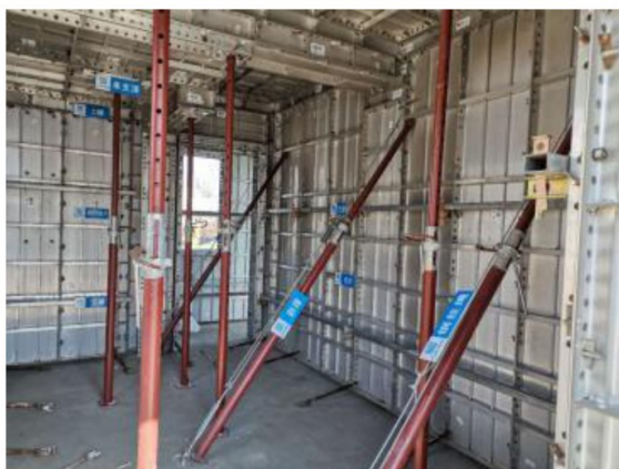
Bố trí cáp thép và cây chống thép để căn chỉnh, ổn định cốp pha tường.
