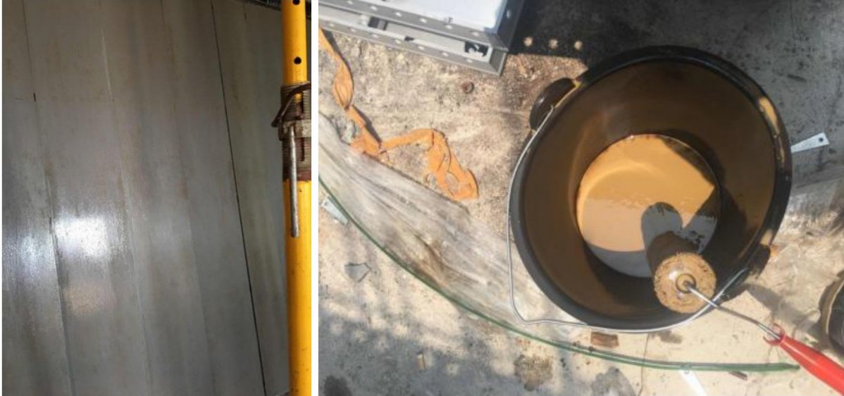
Bề mặt đã quét chất tháo khuôn và thùng chứa chất tháo khuôn.
