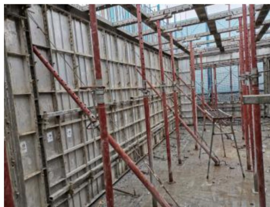
Bố trí cáp thép và cây chống thép để căn chỉnh, ổn định cốp pha tường.
