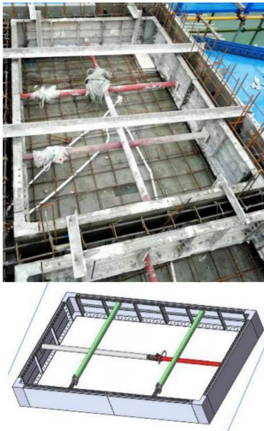
Ảnh hiện trường và mô hình chống đối xứng tại vị trí hạ cốt lớn.
