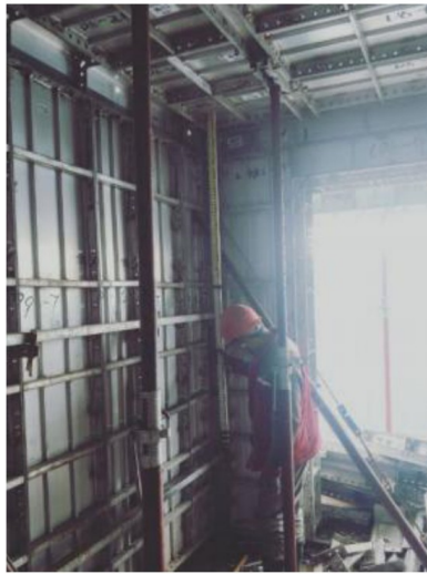
Các hình minh họa đo và điều chỉnh cao độ cốt pha sàn.
