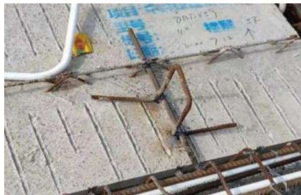
Trái: thép neo trên sàn bê tông đổ tại chỗ. Phải: thép neo chôn sẵn trên sàn bê tông bán lắp ghép.
