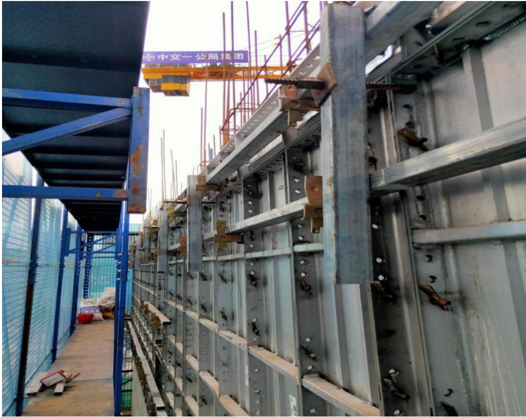
Gông gia cường tấm K và chốt chữ 7 tại hiện trường.
