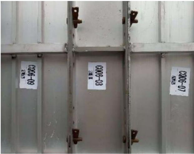
Nhãn mã cấu kiện trên tấm cốp pha.
