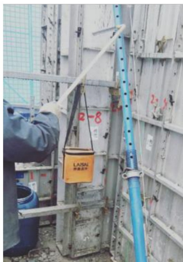
Hình 1, Hình 2, Hình 3 — kiểm tra và căn chỉnh theo tia laser.
