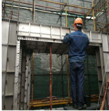
Các hình minh họa lắp cốt pha thành dầm.
